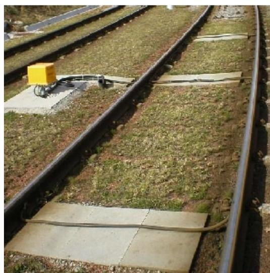
Bild 1.2: Gleisstromkreis mit Sender-
